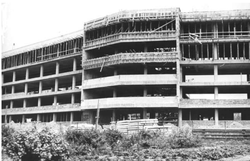
Rozestavěná nová školní budova
